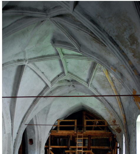
Il 3. Sklepienie nawy bocznej przed uszkodzeniem. Stan z 2012 r. Foto: A. Peszko
