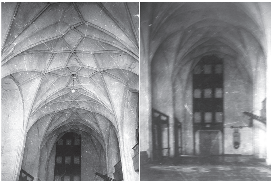
Il. 15. Wnętrze dawnej nawy głównej kościoła pofranciszkańskiego w Brzegu ze zrealizowanymi urządzeniami do ćwiczeń straży pożarnej z ok. 1935 r. Fototeka Wojewódzkiego Urzędu Ochrony Zabytków w Opolu sygn. 0917 i 0918
