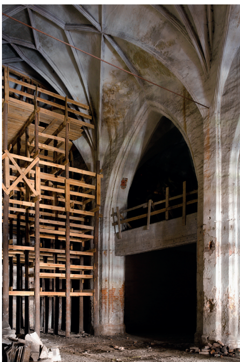
Il. 19. Widok wnętrza nawy głównej w marcu 2021 r. Foto: A. Peszko
